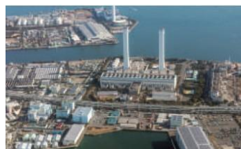
発電・変電所
