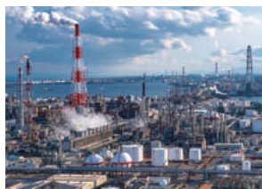
排ガス成分サンプリング・プラント試運転業務
