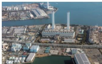
発電・変電所
